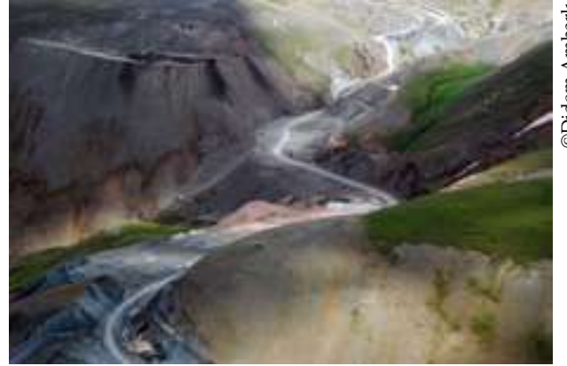
Yol yapımı, Erzurum.
