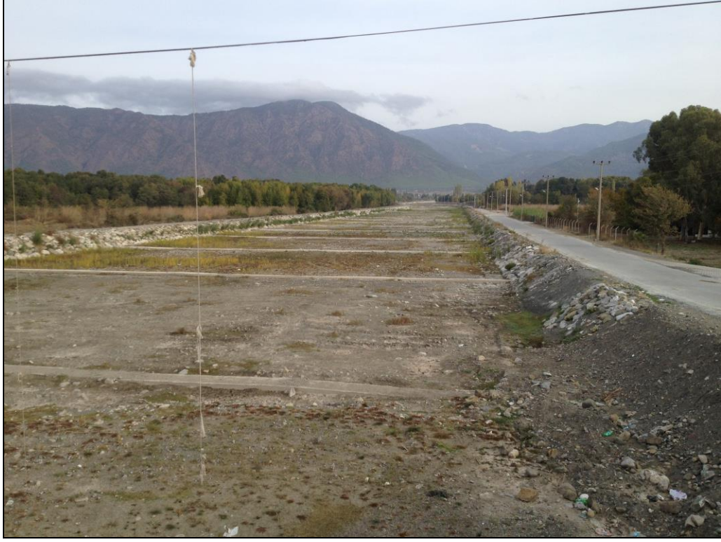
Şekil 24. Kargıcak çayında yapılan seddeler.
